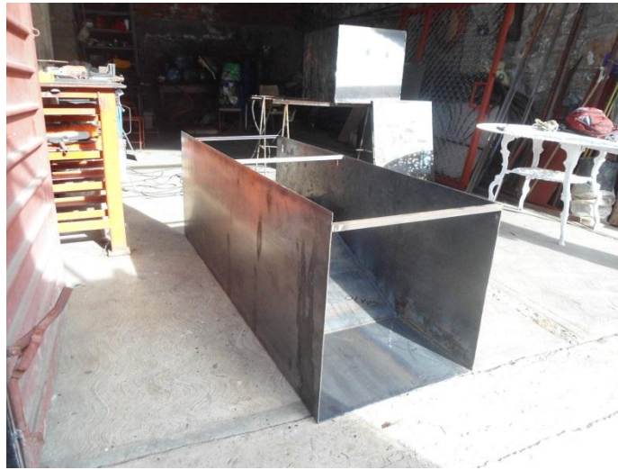
El cuerpo del aforador en construcción
