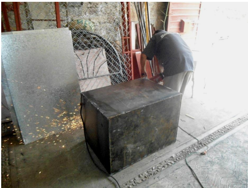
La caja de amortiguación en construcción
