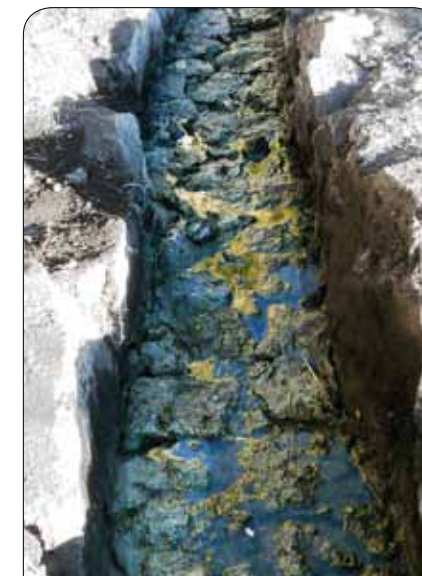
Canal de riego revestido de piedras bajo técnicas ancestrales por la Asociación Andina Cusichaca, Pampachiri, Apurímac, Perú.
