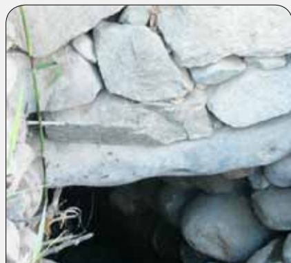
Palo de guarango como techo y canal de salida para regadío, en la galería de Orcona, Nazca, Perú.
