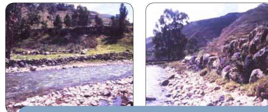
Remanentes de muros del puente incaico sobre el río Nupe, Baños, Huanuco, Perú.
