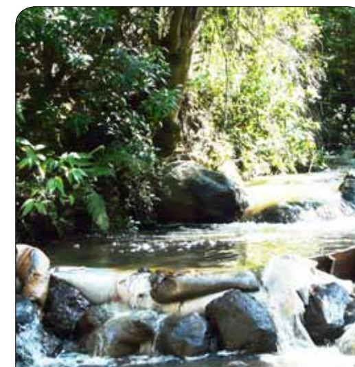
IZQ: Tajamar en Río Grande, Chone, Ecuador. DER: Desvío de agua con sacos de arena en Caldera, Carchi, Ecuador.
