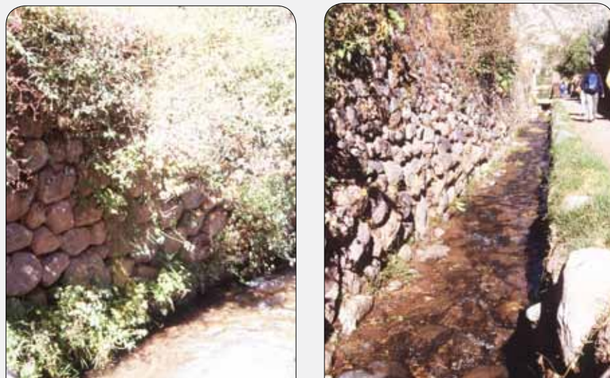
IZQ: Orilla de la quebrada reforzada. DER: Canal revestido desde tiempo incaico, Yucay, Cuzco, Perú.
