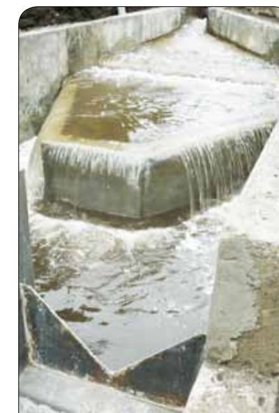
A la izquierda, una presa con tablon de desagüe, vertedero y orificio de caudal ecológico. No se ve la ventana con rejilla para el desvío del agua concesionada.
