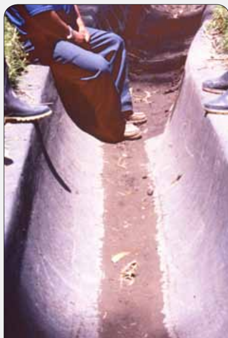
Canal semicircular revestido de terrocemento, Mercedes Cadena, Guamote, Ecuador.
