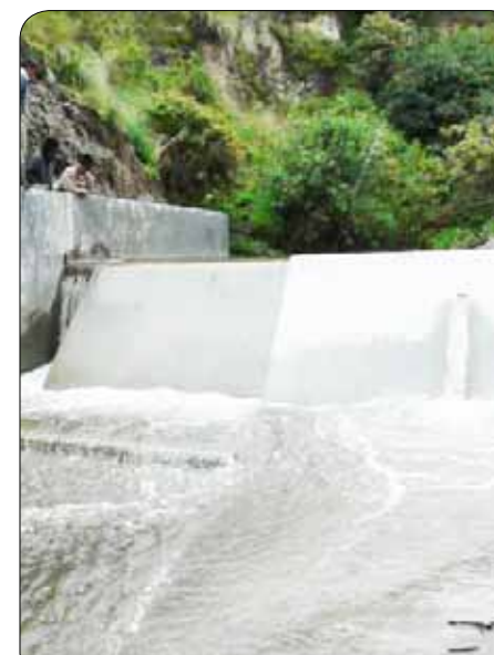
A la izquierda, una presa con tablon de desagüe, vertedero y orificio de caudal ecológico. No se ve la ventana con rejilla para el desvío del agua concesionada.
